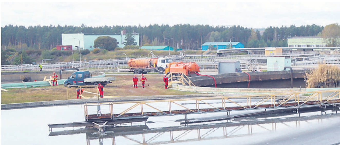
Подрядчиком работ по реконструкции ЛИСА стала фирма из Санкт-Петербурга — ООО «Иннотехмаш»
